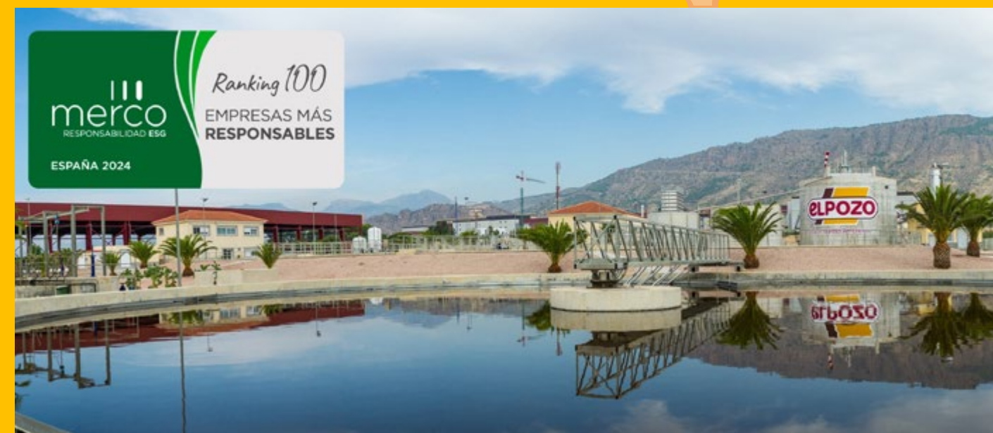
El Pozo Alimentación, en el top 100 de las empresas más responsables de España. Vista aérea de su planta de depuración de aguas.
